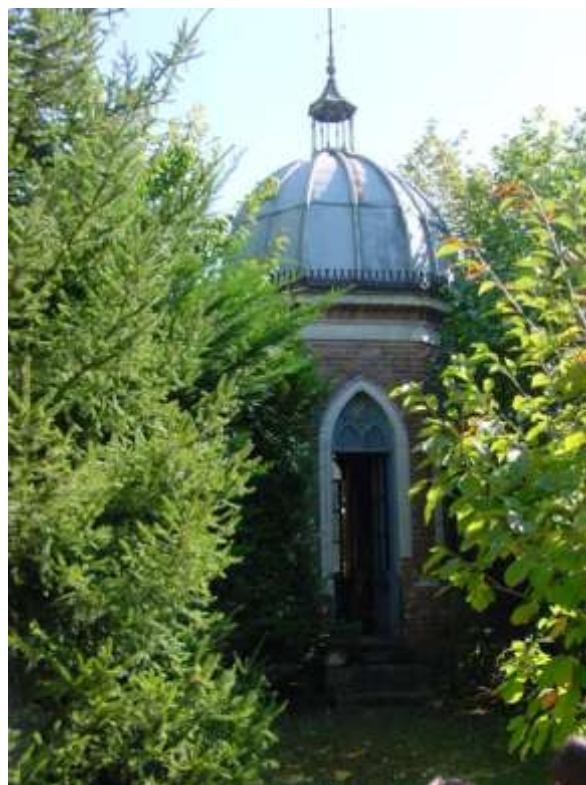
Photo 9 Tour en briques
